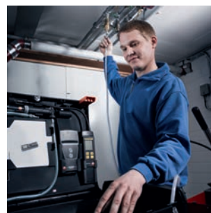
Trink- und Abwasserleitungsprüfung mit Hochdrucksonde bis 25 bar
