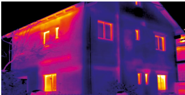
Gebäudeanalyse: Wärmeverluste, Baufeuchte und Schimmel aufspüren.
